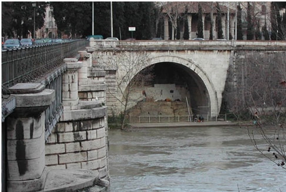
Salida de la Cloaca Máxima en el río Tíber, Roma. La Cloaca Máxima era la red de alcantarillado construida en Roma para drenar los valles locales y eliminar los desechos de la ciudad. De acuerdo con la tradición, su construcción empezó bajo el reinado del primer monarca etrusco, Tarquinio Prisco.
